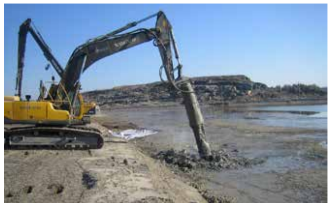
Massastabiloinnissa yhteen ruutuun syötettiin 13 tonnia sementtiä. Kokonaissementtimäärä oli 70 000 tonnia.
