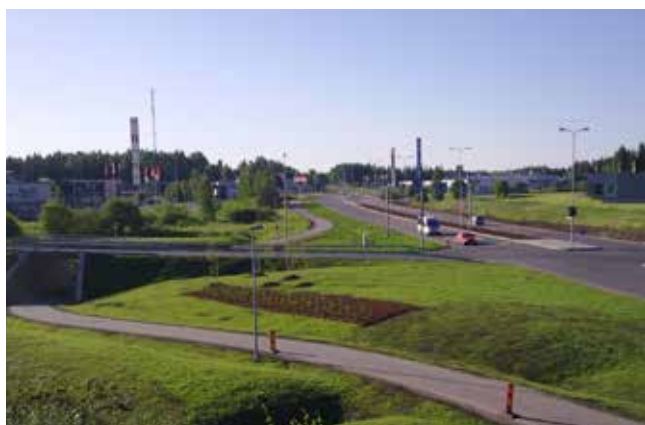
Näkymä Viipurintien eritasoliittymästä Vainikkalaan päin.
