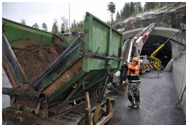
Mullansiirtoon tunnelien päälle käytettiin hihnakuuljetinta.
