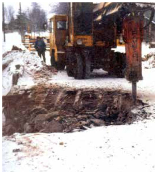
Rammeri piikkaustöissä.
