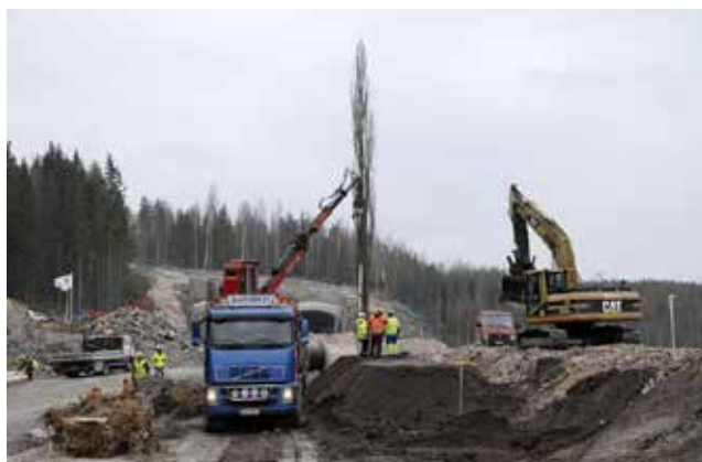
Pylväshaavat nostettiin ja pidettiin tukemisen ajan pystyssä koura-autolla. Puut istutettiin moottoritien keskikaistalle liito-oravien välilaskupaikaksi.
