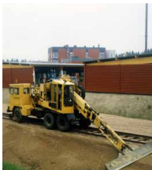
Ratatöiden tekoa Ekokemin teollisuusraiteilla Riihimäen uuden polttolaitoksen valmistuessa.
