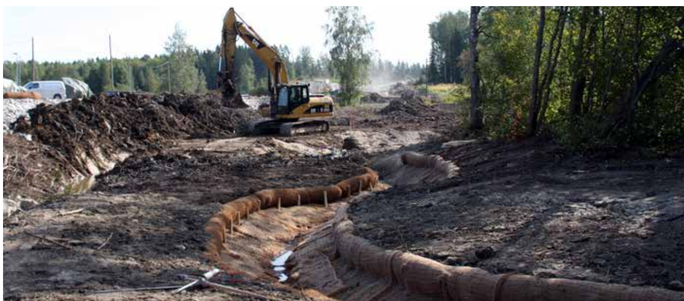
Vantaan Kylmäojan työmaa alkuvaiheessa.
