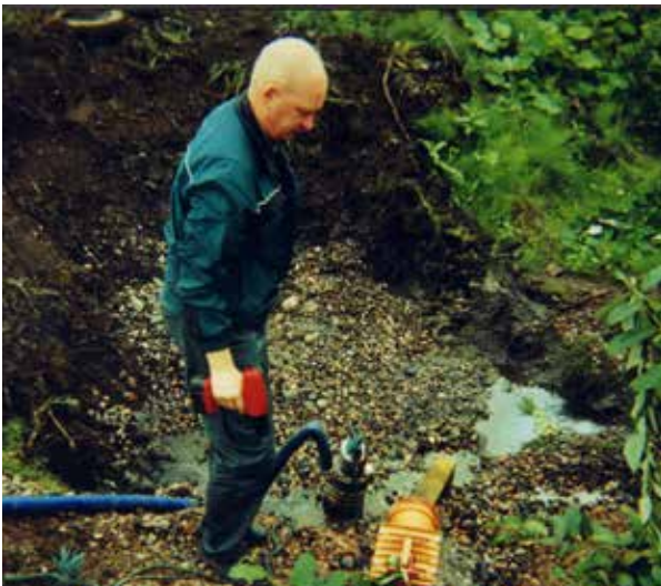
Markku Hurskainen asennustöissä.
