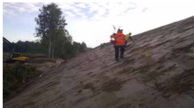
Metsitystaimien istutustyöt käynnissä Lauritsalan meluvallin takaluiskassa.
